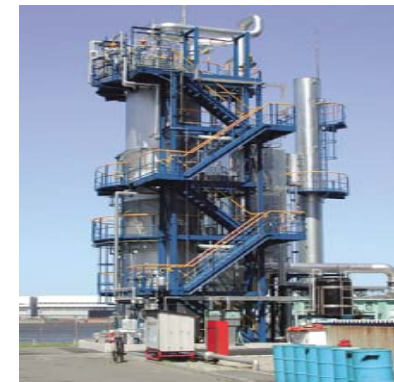
インシネレータ（廃ガス廃液焼却炉）
