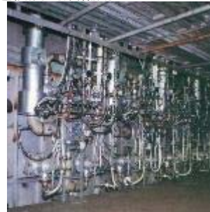
連続焼鈍設備用HRSRTバーナ
