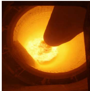
特殊熱風発生炉(高圧型)
